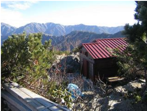
改修中の塩見小屋
