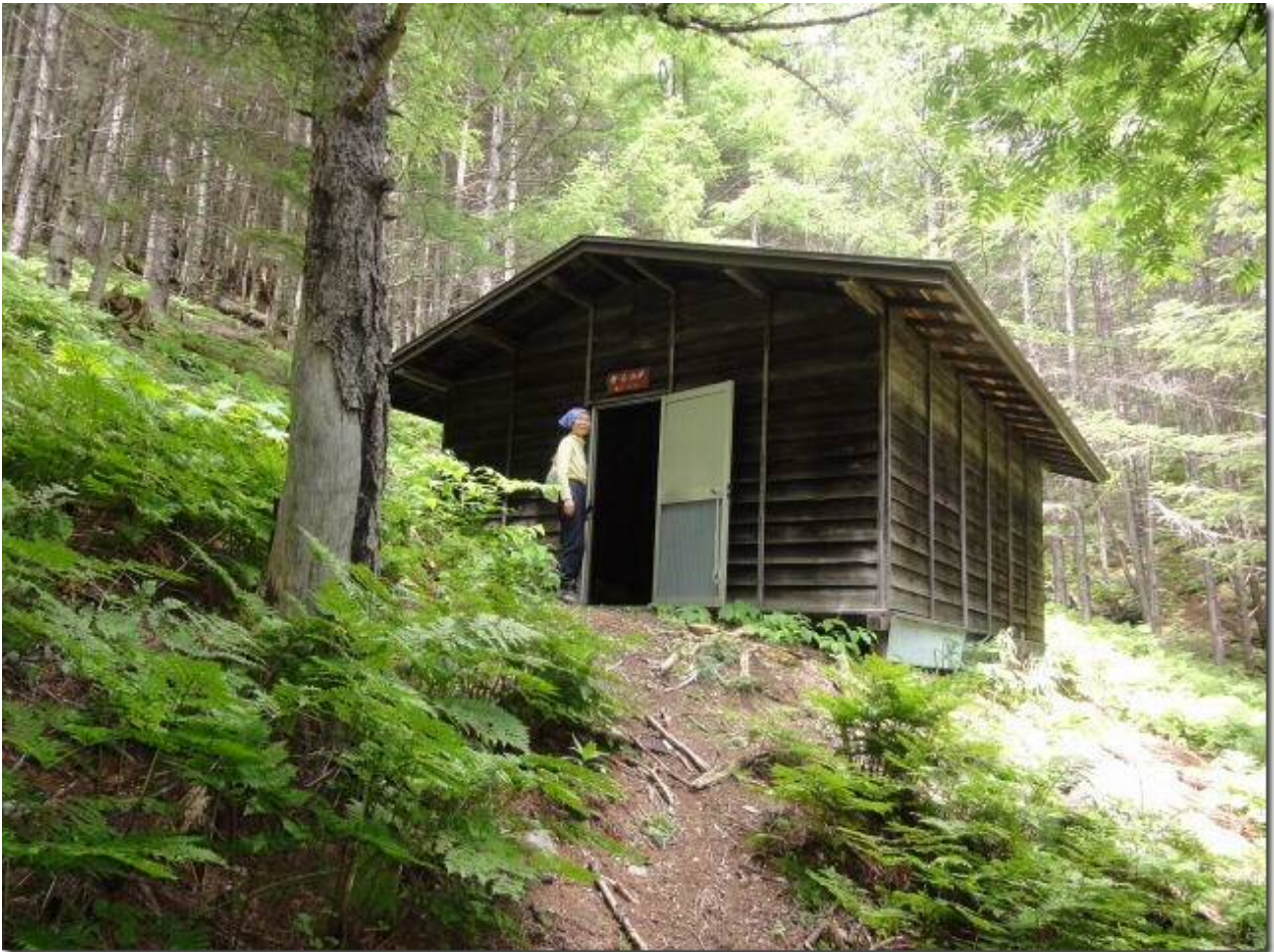
松峰小屋全景
