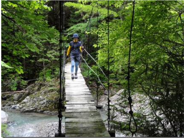
登山道へ入るとすぐに吊り橋。定員一人
