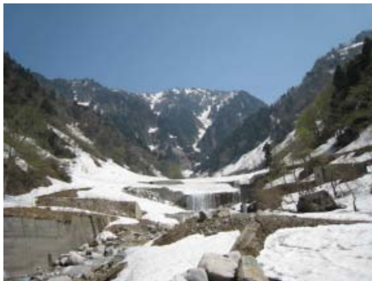
阿部木谷 920m えん堤 幕営地点より
